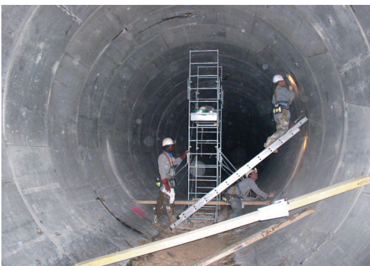
Photo 10 : Mesures géotechniques in situ (Cliché F. Dureux)
